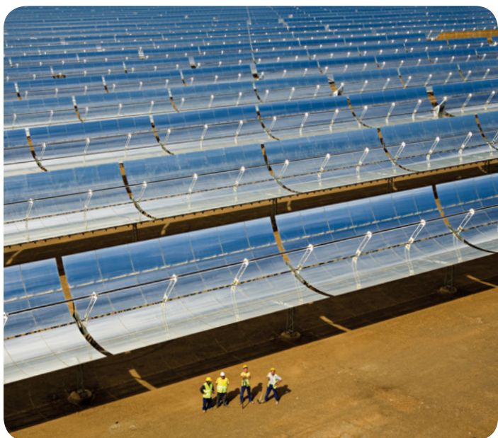
Cilindro Parabólico , Planta Termosolar De Villena (Base Sorlareserve)
