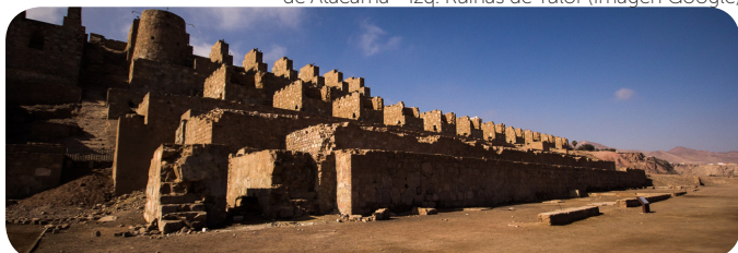
Legado Arquitectónico - Ruinas de Huanchaca (Imagen Google)
