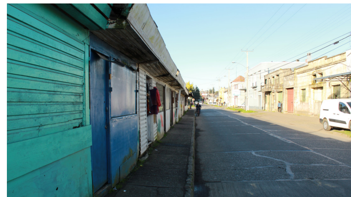
Imagen 47: Antigua feria artesanal de Nueva Imperial, hoy en notable situación de abandono y deterioro. Fuente: Imagen propia
