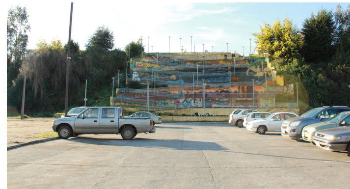
Imagen 46: Acceso peatonal Avenida Prat. Una de las últimas inversiones públicas en el sector, consiste en una rampa diseñada bajo parámetros de accesibilidad universal que permite la comunicación entre Imperial "Alto" e Imperial "Bajo". Fuente: Imagen propia
