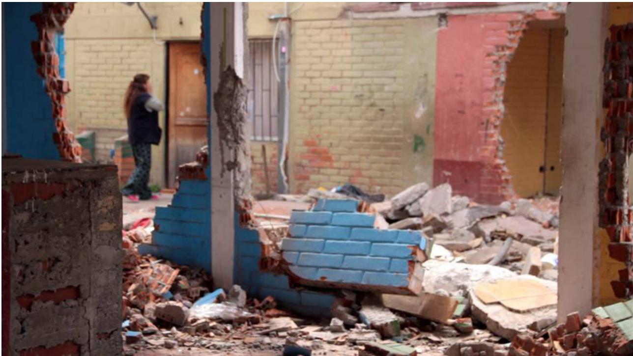
Demolición de Blocks, primer llamado programa segunda Oportunidad. Fuente: www.google.cl
