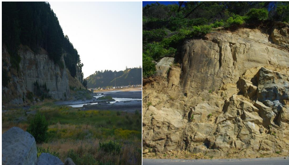
Figura 34: Caídas de roca en Tubul (Izq), y en el camino de Llico a Pta. Lavapié (Der.).
