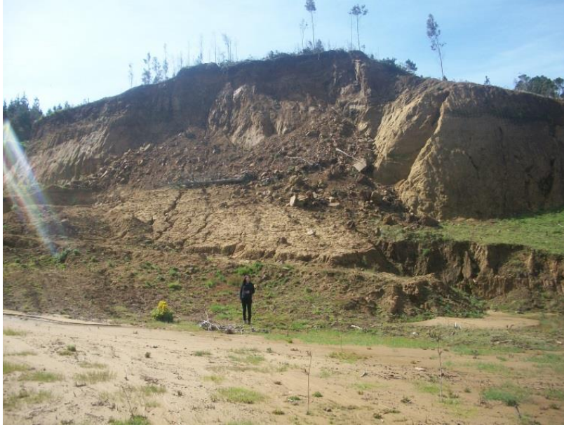
Figura 32: Deslizamiento de roca en Piuré
