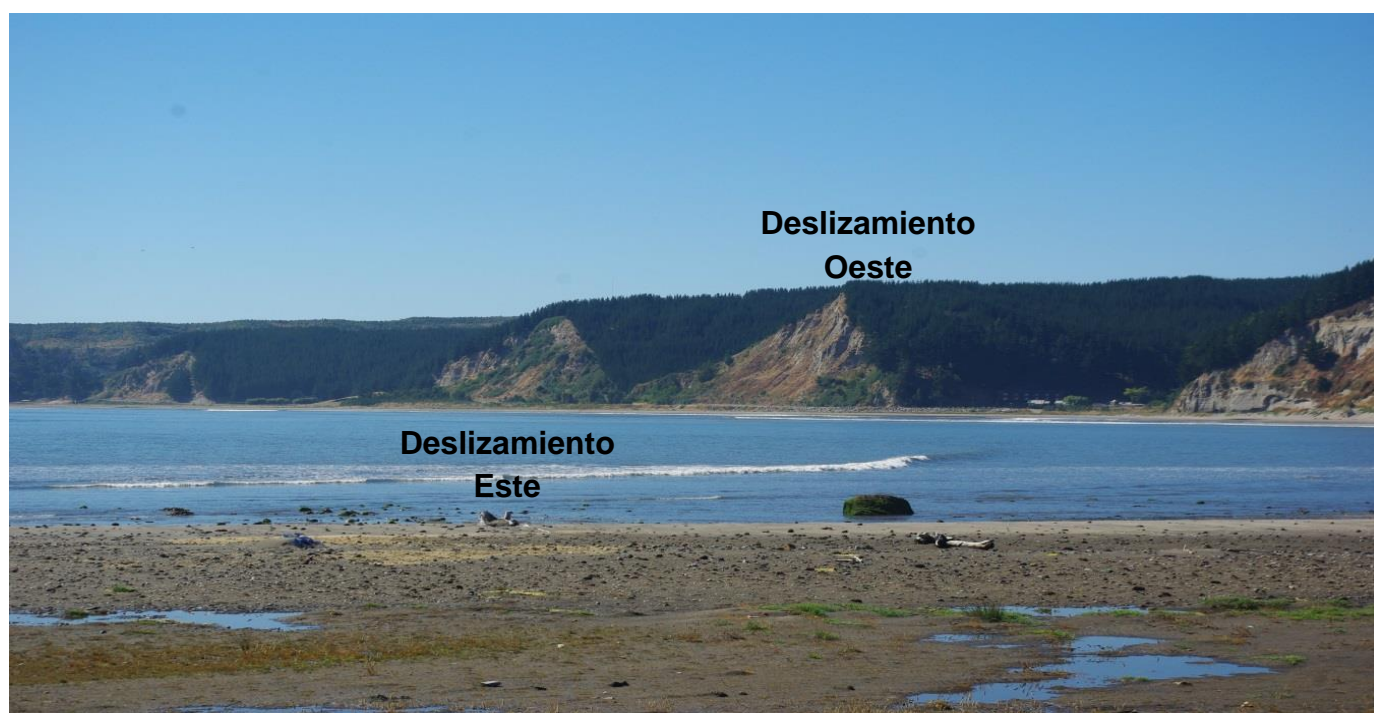
Figura 29: Vista general deslizamientos de caleta Tubul.
