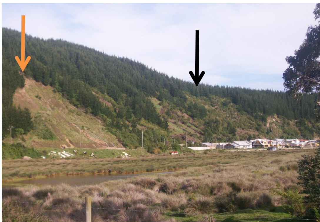
Figura 26: Deslizamientos de suelo Caleta Las Peñas. Vista hacia el Sur.
