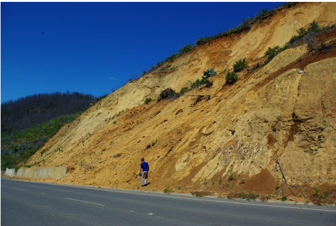
Figura 25: Deslizamiento de suelo en camino Llico-Pta Lavapié.
