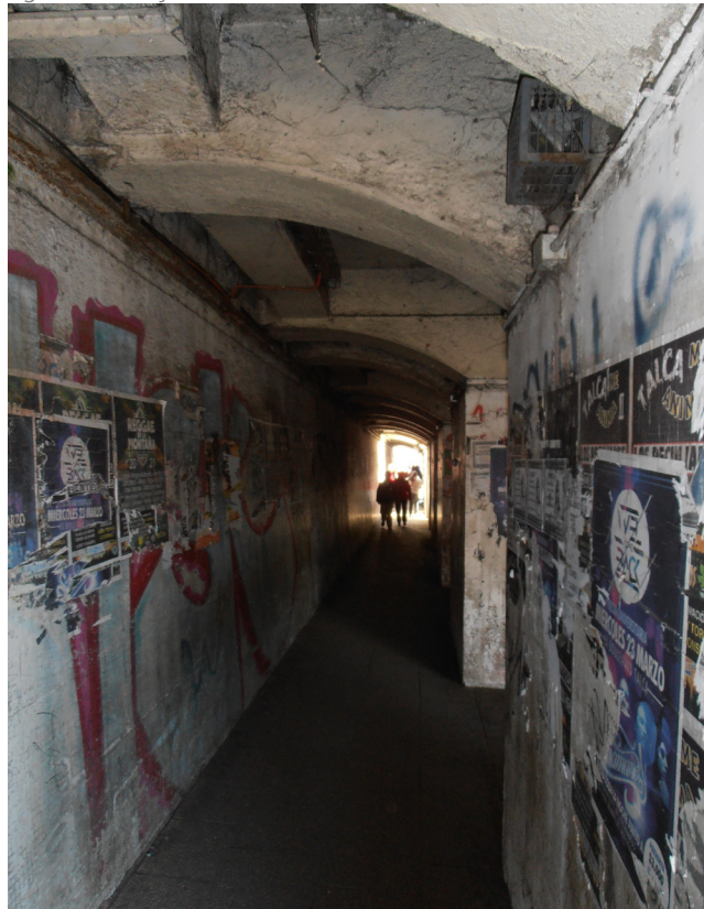
Fig. 18 Paso bajo nivel 1 Sur
