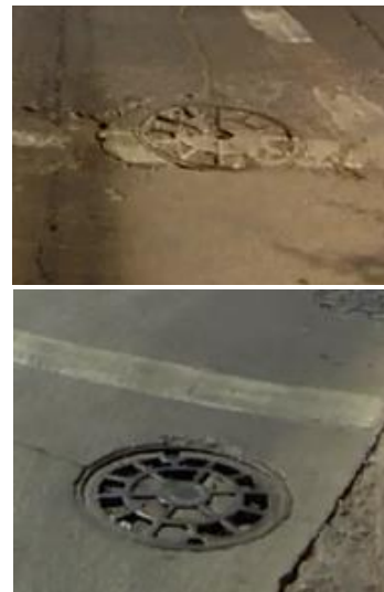
Figura 21. Imágenes de sumideros y cámaras de intersección como peligro de desvío o accidentabilidad de ciclista.
