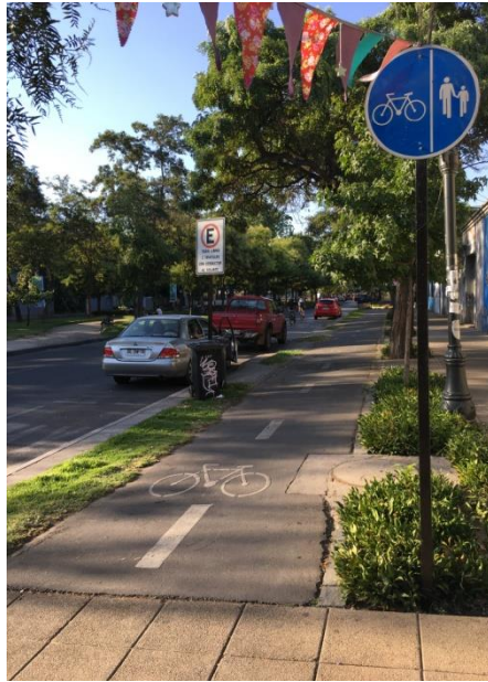
Figura 45. Acceso ciclovia en acera, vista costado de Gral. Bustamante hacia el norte.
