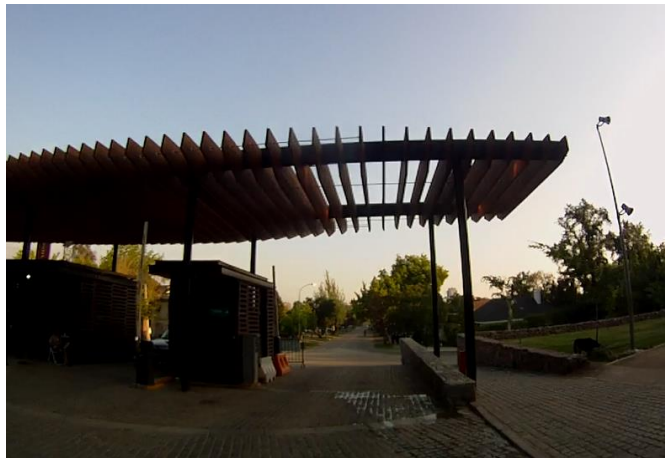
3. Vista del pórtico del acceso al parque e inicio de muro separación.
