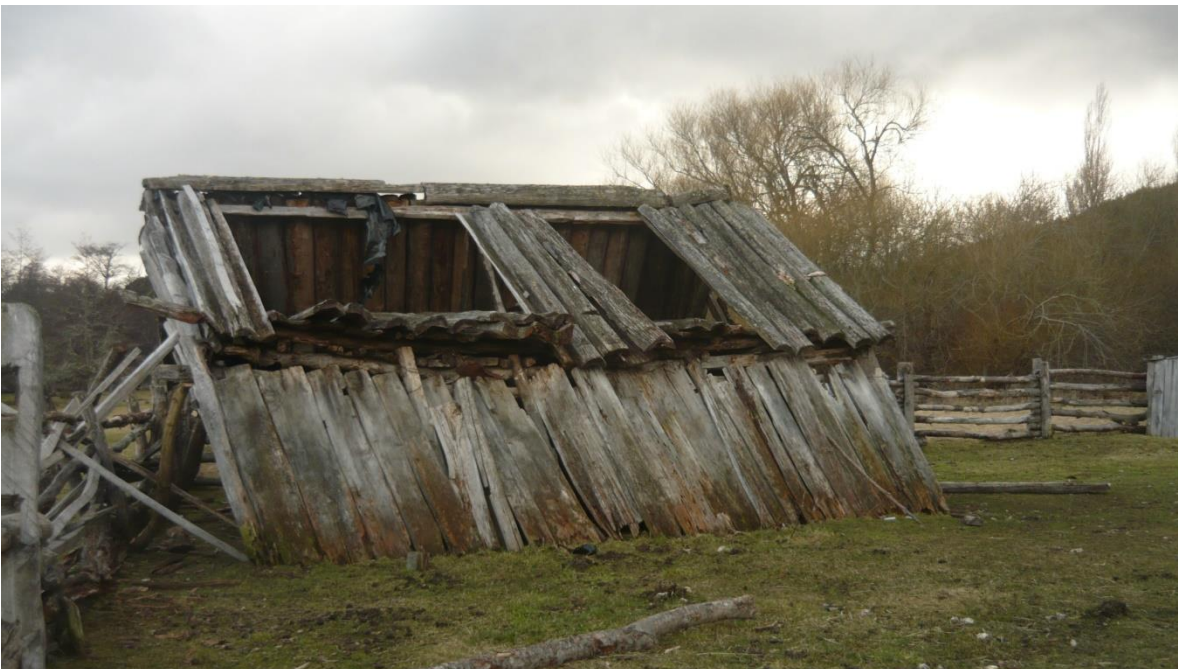
Foto n°4: Infraestructuras de canoga y tingle antiguos, donde se observa el uso exclusivo de recursos naturales para la edificación.
