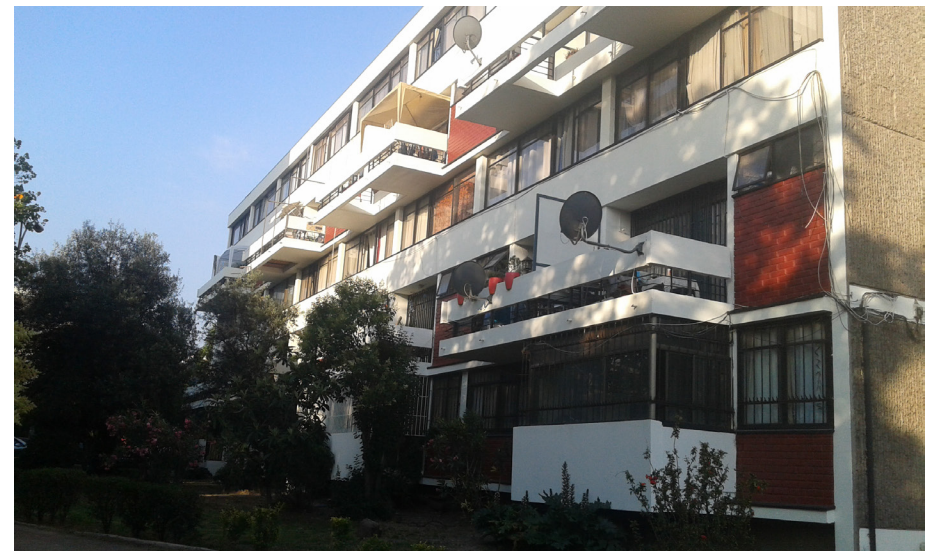
Figura 14. Jardines exteriores bordeando los bloques de viviendas. Fuente: Elaboración propia.
