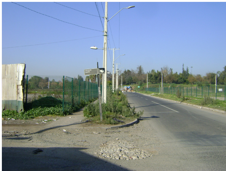
Figura 65. Vista hacia el sur desde Callejón Ugarte con General Amengual. Fuente: Elaboración propia.
