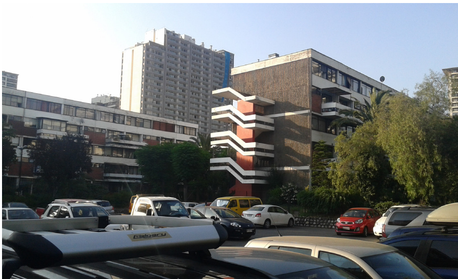
Figura 12. Vista desde la zona de estacionamientos hacia el norponiente. Fuente: Elaboración propia.
