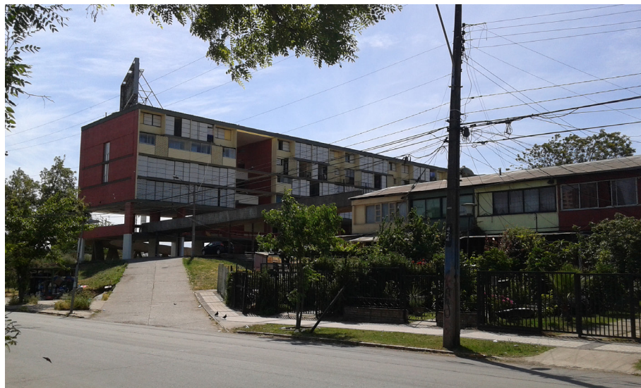
Figura 10. Vista del acceso por calle El Belloto hacia el norponiente. Fuente: Elaboración propia.
