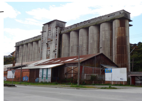
Edificio Silos en primera terrazza
