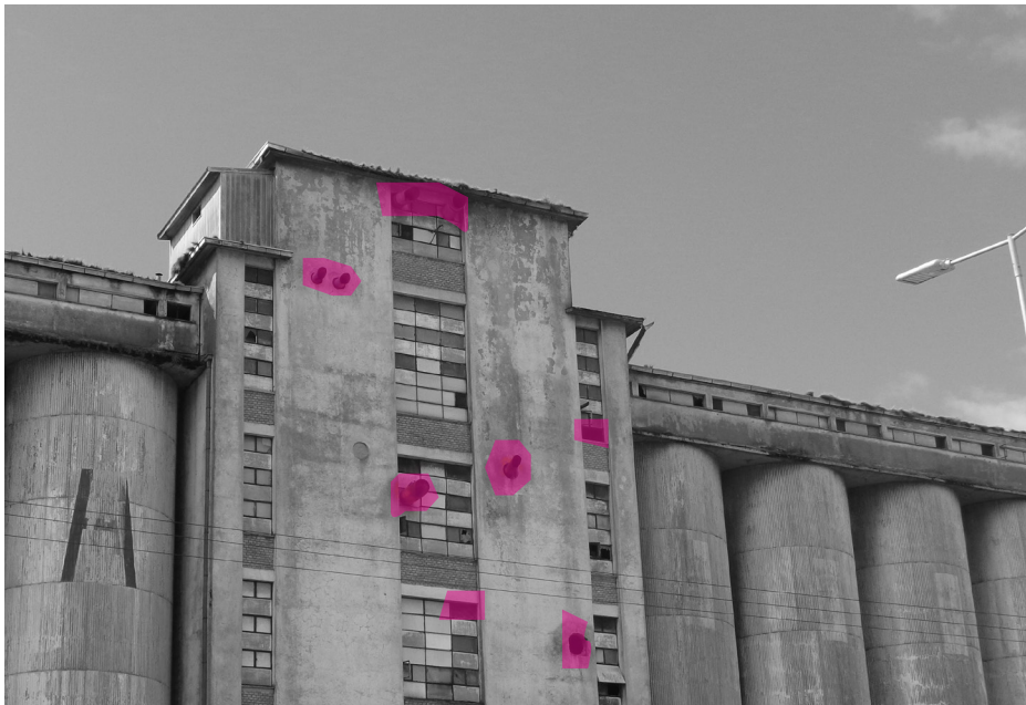
PERFORACION DE FACHADA
