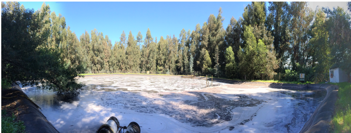
Figura 4. Fotografía piscina de residuos líquidos
