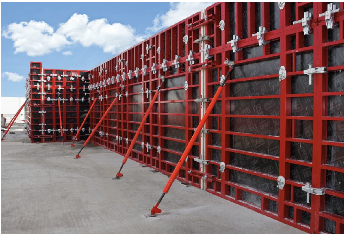
Figura 2: Encofrado Modular Bastidor Metálico con Placa Fenólica.
