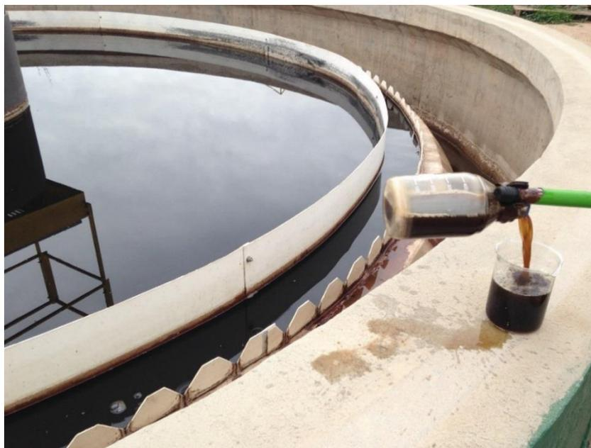
Figura 11.1. Toma de muestra a la salida de un sedimentador.
