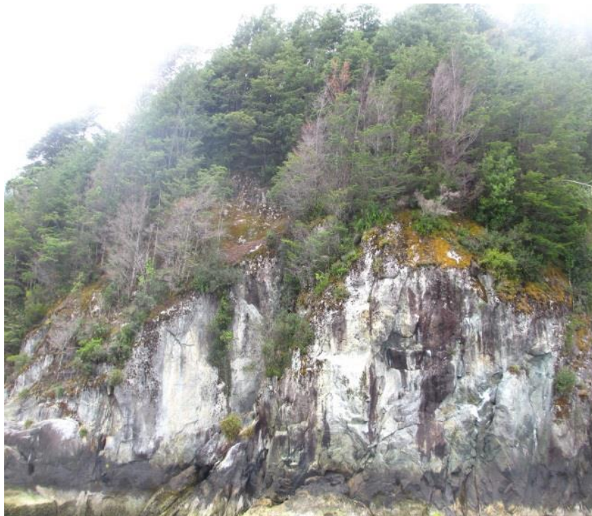
Figura 24: Caída de roca en ladera Este fiordo. Fuente: FONDECYT N° 1151087.
