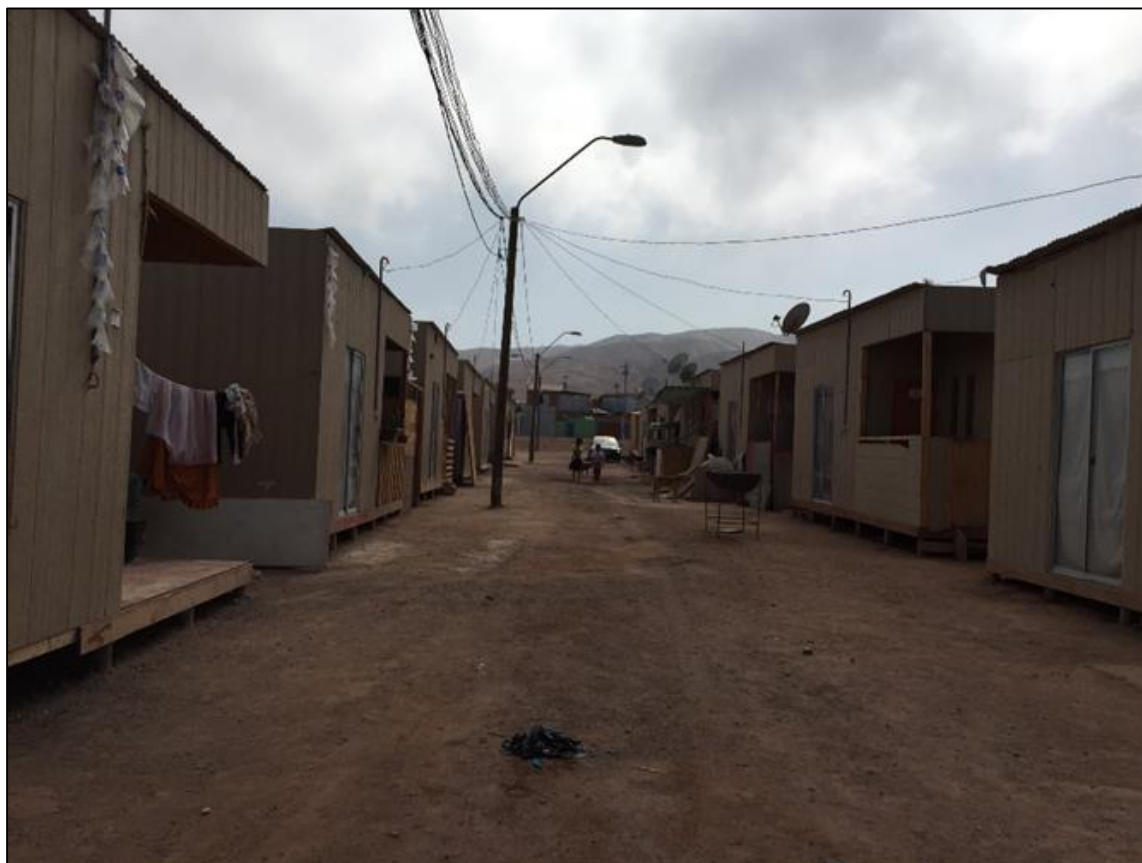
Figura 22: Estructura de vivienda Barrio La Negra, Alto Hospicio Fuente: Fotografía tomada en terreno. Octubre de 2015
