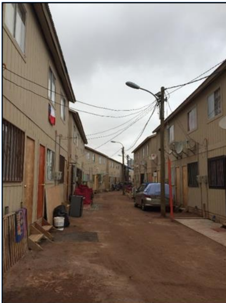
Figura 18: Estructura viviendas Barrio de Emergencia Mirador, Iquique Fuente: Fotografía tomada en terreno. Octubre de 2015.
