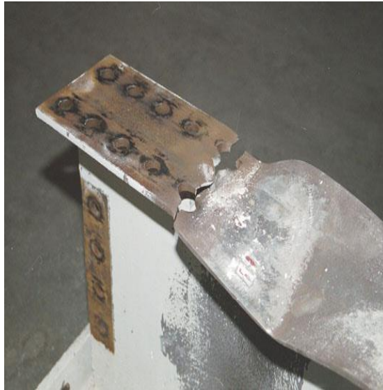
Figura 1.5: Falla por fractura del área neta del ala de la viga (Smallidge, 1999)
