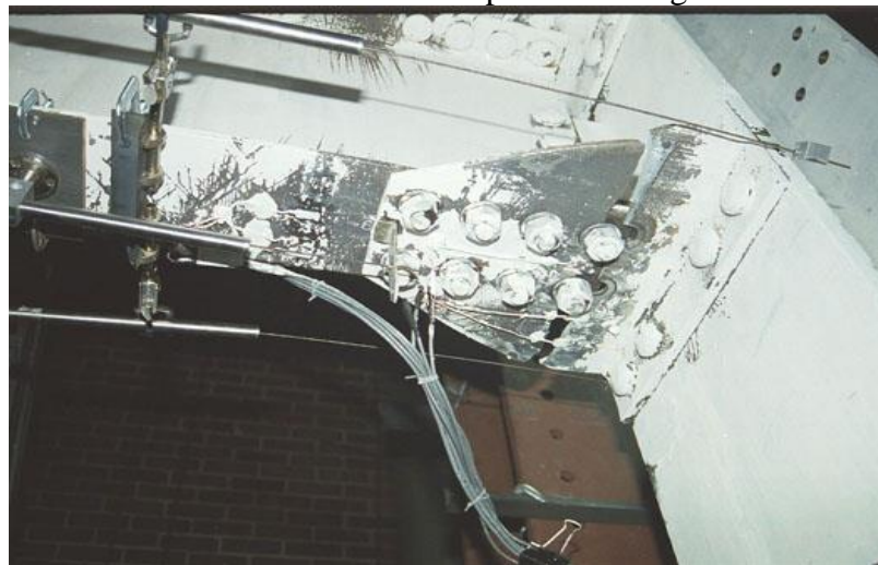
Falla por fractura de área neta del alma de la T Stub
