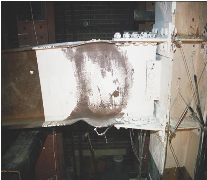
Figura 1.6: Formación rótula plástica en la viga y pandeo local post fluencia del ala y alma (Smallidge, 1999)
