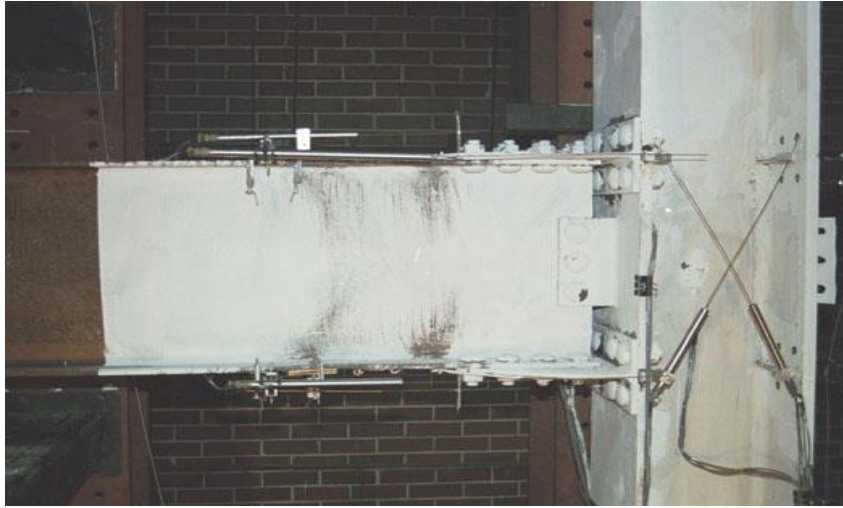
Rotula plástica con compromiso de la estabilidad del ala de la viga
