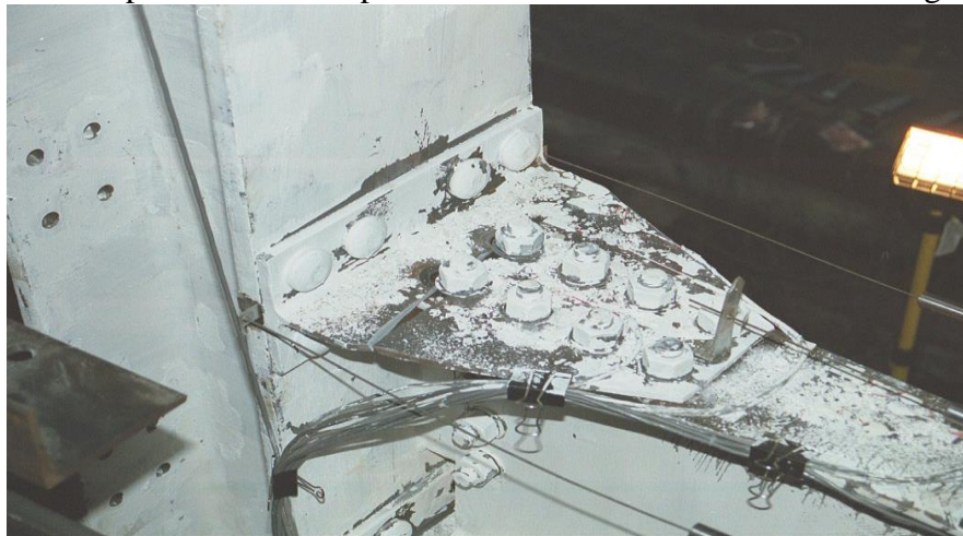
Falla por fractura de área neta del alma de la T Stub
