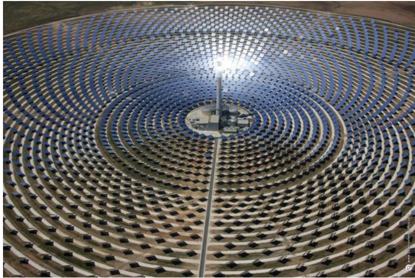
Figura 3.19 Planta termosolar Gemasolar Fuente 21
