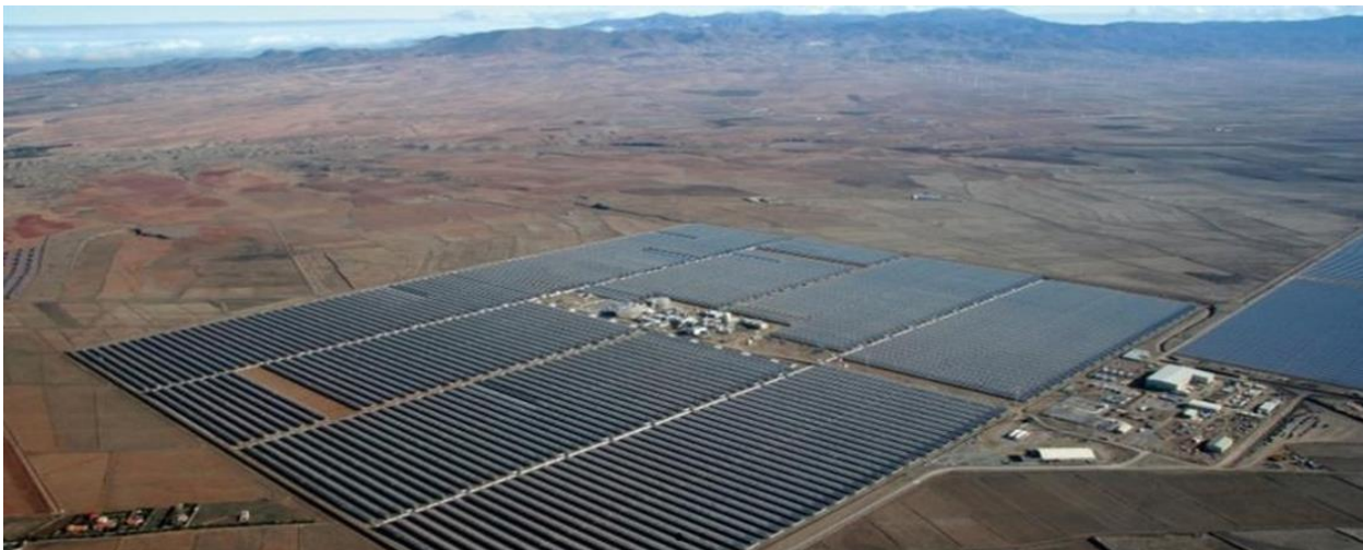
Figura 3.6 Planta termosolar Manchazol
