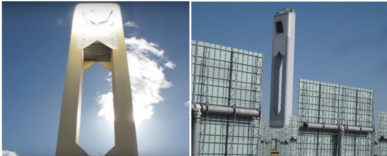
Figura 3.13 Receptor de cavidad de central PS10 Fuente 15
