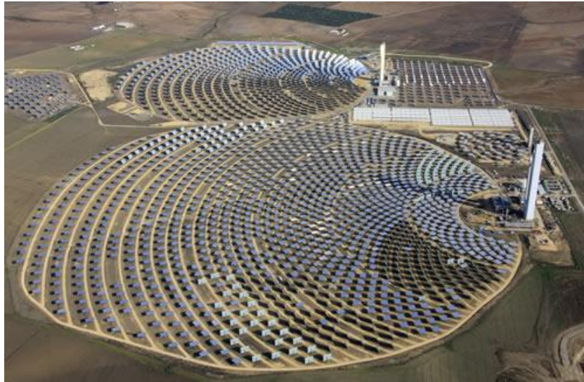
Figura 3.20 Planta termosolar PS20 (en el fondo planta PS10) Fuente 22
