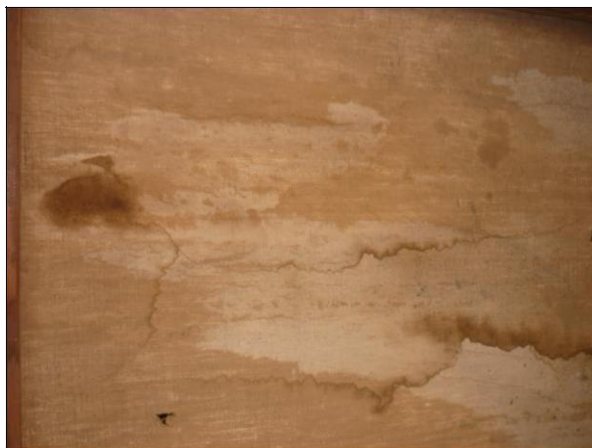
III 15 Aspecto general de la tela de la obra.
