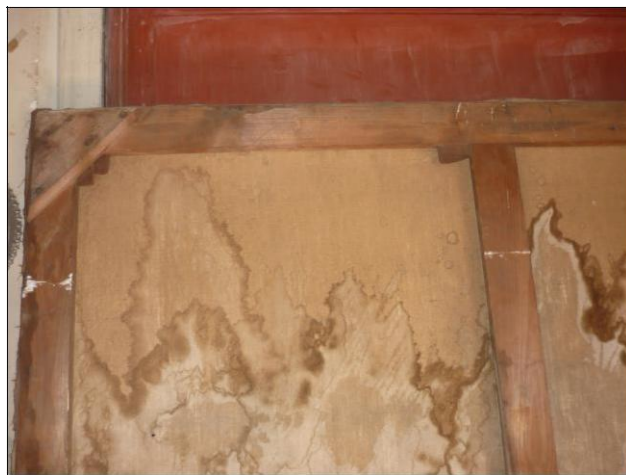
III 14 El sistema de cuñas también se puede apreciar en el travesaño central.
