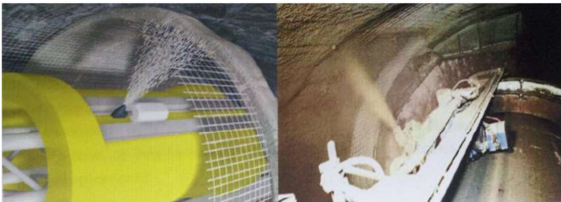
Figura 3.9: Fortificación mecanizada para TBM tipo Gripper.
