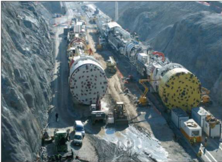
Figura 3.6: TBM abiertas utilizadas en los túneles de Lotschberg(Suiza y San Pedro (España)).
