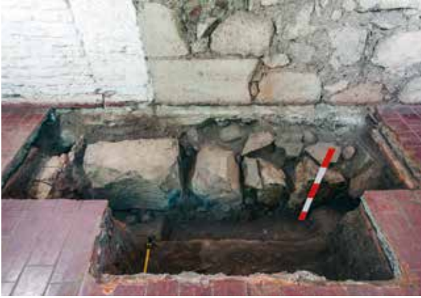
FIG 9 Vista frontal del sistema de cimientos / Front view of the foundation system. Fuente / Source: FONDECYT N° 11130628
