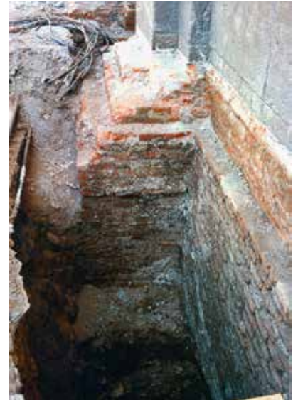
FIG 12c Cimientos de piedra con argamasa de la ex Real Audiencia de Santiago. Excavaciones realizadas en el marco de la construcción de la Estación Metro Plaza de Armas / Stone and mortar foundation of the former Real Audiencia in Santiago. Excavations performed during the construction of Plaza de Armas Subway Station. Fotografía / Photograph: Claudia Prado, 1997.
