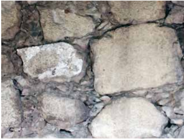
FIG 4a Detalle mampostería de piedra original / Original stone masonry detail. Fuente / Source: FONDECYT N° 11130628
