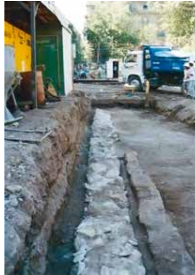
FIG 12b Cimientos de piedra con argamasa de cal del antiguo mercado de la Plaza de Armas de Santiago / Stone and lime-mortar foundation of Santiago's ancient market at Plaza de Armas. Fotografía / Photograph: Claudia Prado. Fuente / Source: FONDECYT N° 1090325
