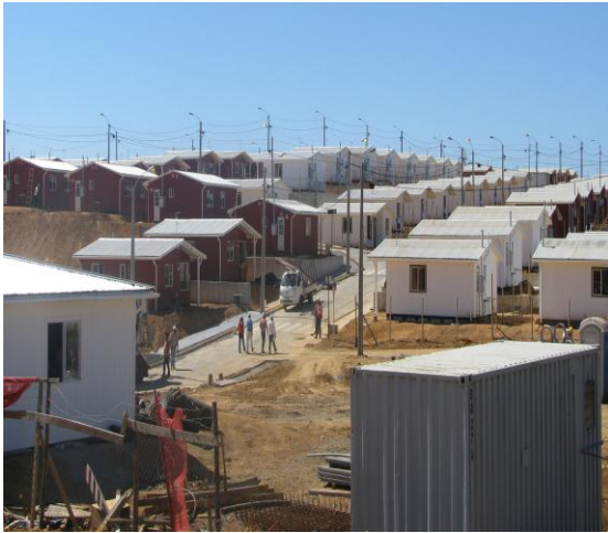
Imagen 13: Villa Horizonte, viviendas prefabricadas Fuente: Elaboración propia
