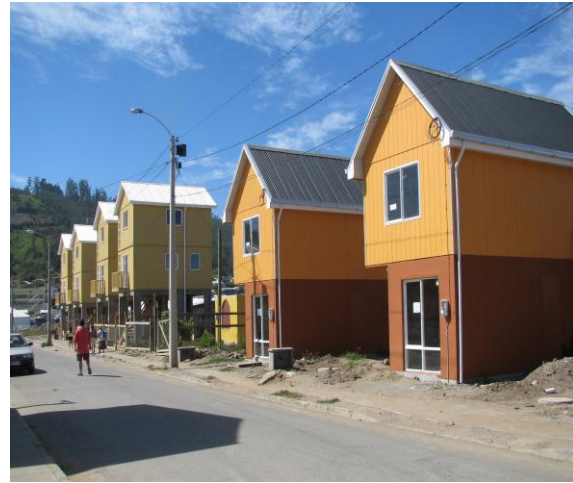
Imagen 14: Construcción de viviendas en terreno propio. Fuente: Elaboración propia
