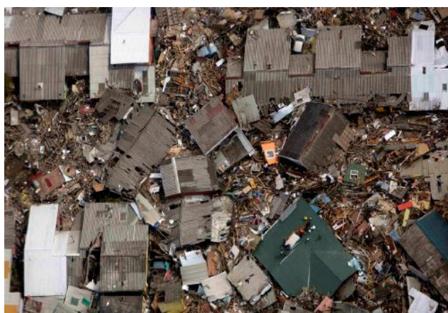
Imagen 6: Centro Urbano de Dichato destruido.
