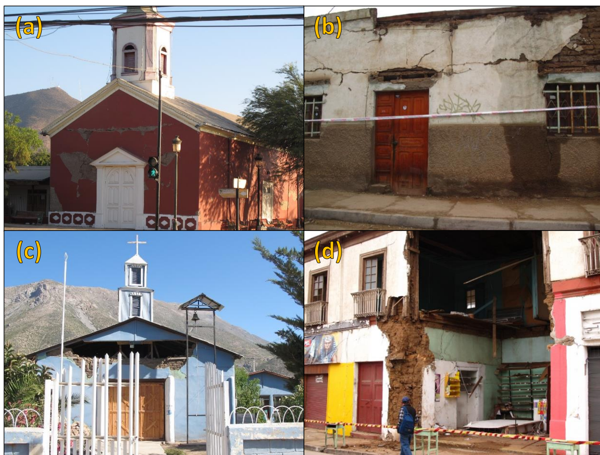
Figura 25 – Fotografías evidenciando daño provocado por el terremoto de Illapel 2015 en algunas localidades de la Región: (a) Iglesia de Monte Patria, (b) vivienda en Illapel, (c) Iglesia en Pedregal y (d) vivienda en Ovalle (Tomadas en enero 2016).
