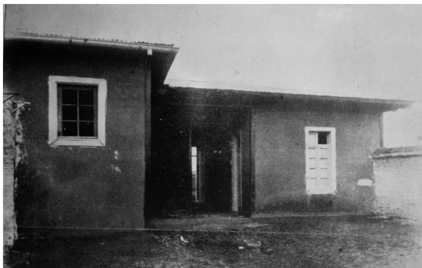
“Interior de una casa de la población Matadero”, construida por el CSHO. Fuente: CSHO. Memoria de su labor. 1911-1912.
