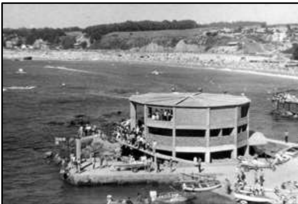
Imagen 6. Construcción del Club de Yates El Quisco y vista parcial de playa Los Corsarios Galería Fotográfica Club de Yates El Quisco
