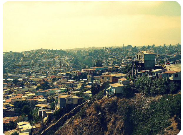
Ascensor Las Cañas fuera de funcionamiento. Autor: Anónimo.
