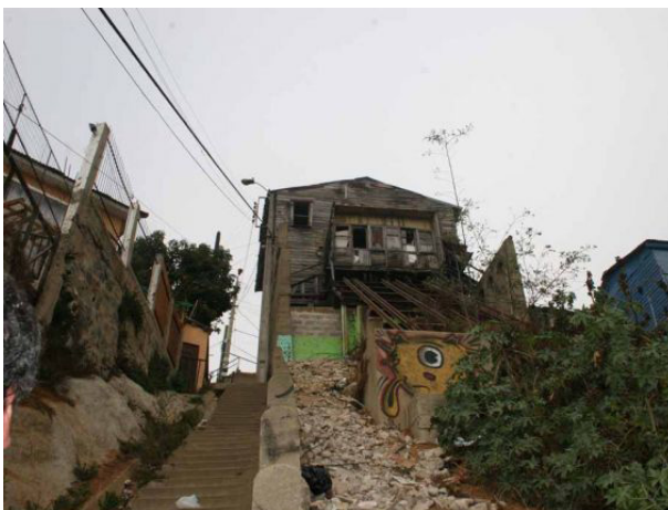
Antiguo ascensor Las Cañas. Fuente: Archivo personal.
