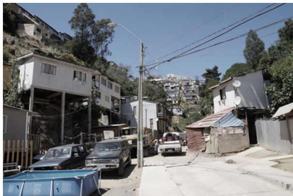
Viviendas en fondo de quebrada. Fuente: Archivo personal.
