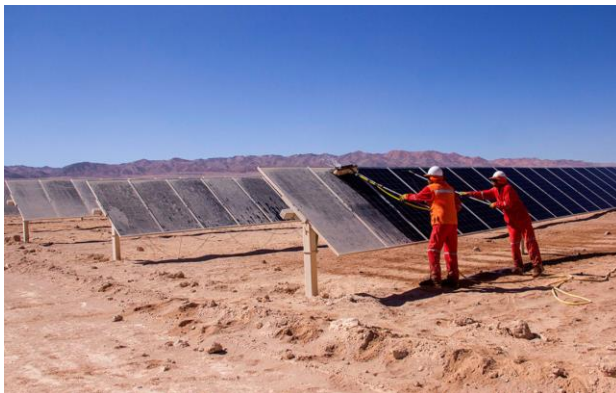
Fuente: Parque solar Andes Solar, Antofagasta.
