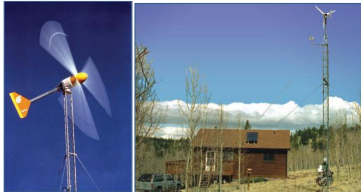
Figura 17. Aerogeneradores para Aplicaciones Aisladas.
