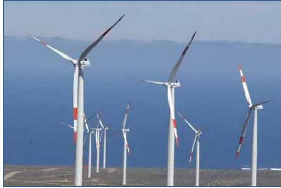
Figura 16. Parque Eólico Canela (Endesa), Ubicado en la Región de Coquimbo Chile.
