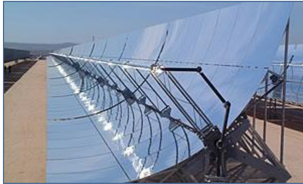
Figura 4. Colectores Cilíndrico-Parabólicos, Planta de Generación de Electricidad.
