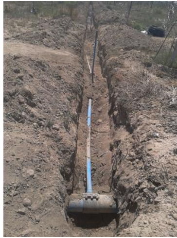
Figura 4. Arranque de riego desde la matriz principal y válvulas programables.
