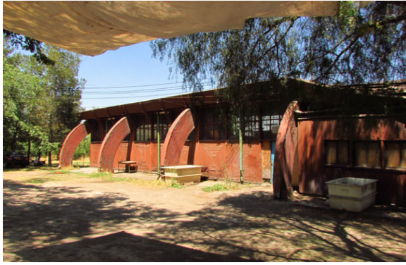
(a) Tramo inicial curvo en el exterior.
