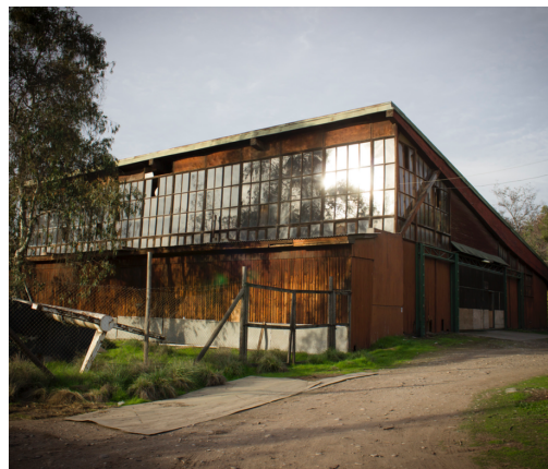
Figura 2.5: Vista del muro poniente. Fuente: Egaña (2016).
