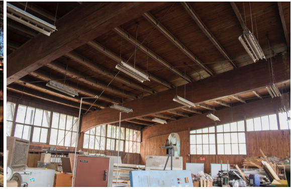
(b) Tramo recto al interior de la estructura.
