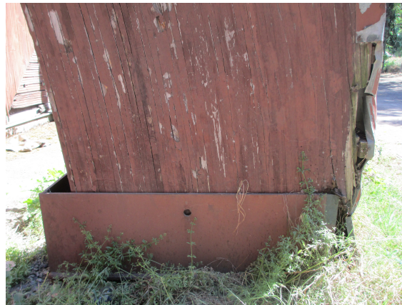
(c) Apoyo sobre perfil de acero.
