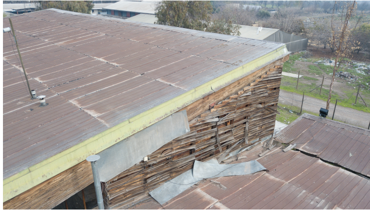
Figura 3.3: Fachada sur del galpón. Fuente: Elaboración propia.
