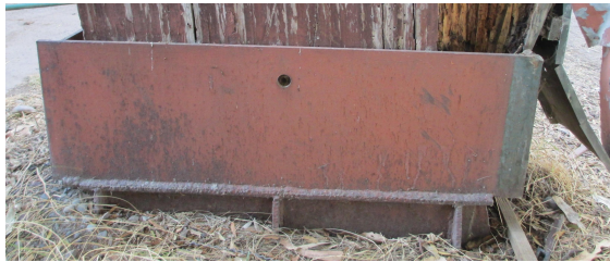
Figura 3.8: Perfil de acero utilizado en la reparación. Fuente: Elaboración propia.
