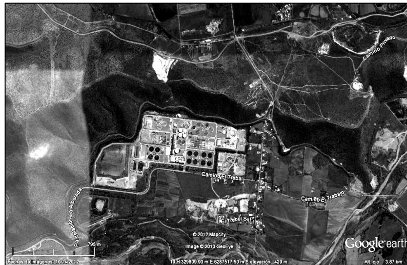
Figura 2: Vista de la planta de tratamiento de aguas servidas El Trebal. Ubicado en la comuna de Padre Hurtado.
