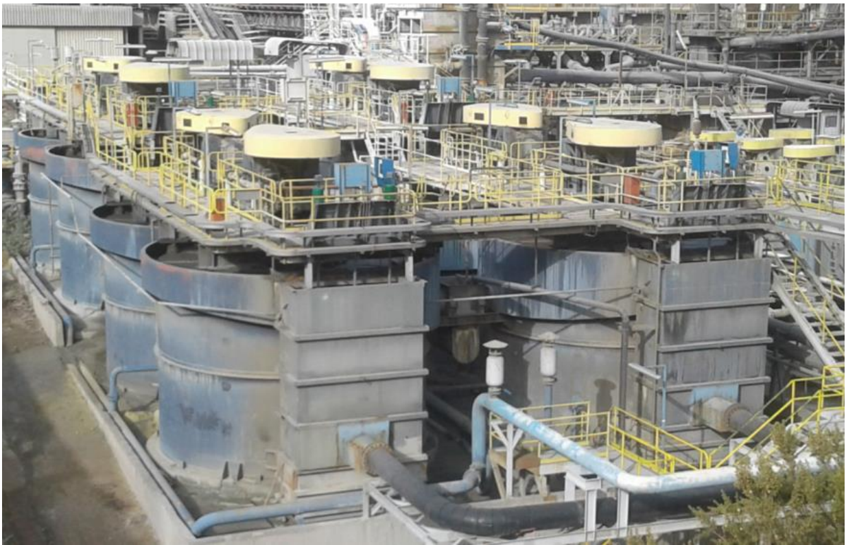
Figura 30 Circuito de flotación rougher relaves Cauquenes. Banco 100 (izquierda) y 200 (derecha)
