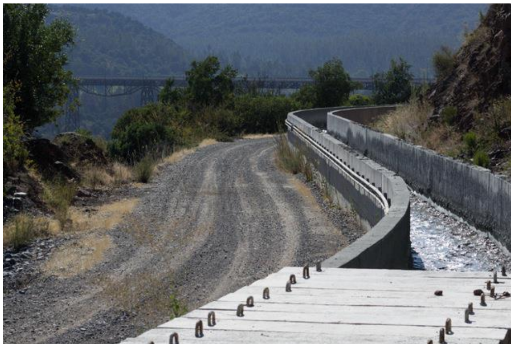
Figura 25 Canal de relaves frescos provenientes de El Teniente (Henderson, 2016)
