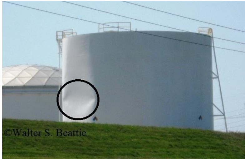
Figura 2.11: Abolladura en estanque vertical producida por vacío (Fotografía extraída desde el sitio de Walt Beattie [18]).
