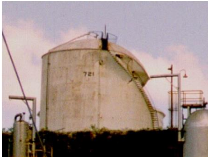
Figura 2.19: Pandeo global en estanque vertical (1)[32].
