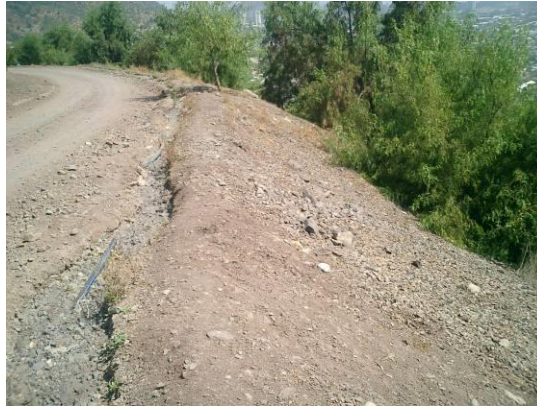
Figura 9. Cortafuego Camino Digeder (El cortacombustible a su costado se efectuó mediante despeje parcial de la vegetación, esparciendo astillas sobre el).
