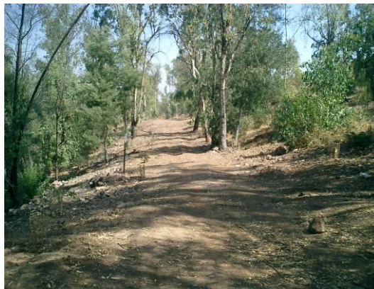
Figura 11. Cortafuego Camino La Pirámide (en sus costados el cortacombustible se efectuó mediante despeje parcial de la vegetación sin extraer árboles grandes).
