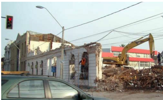
Banco BCI en demolición
