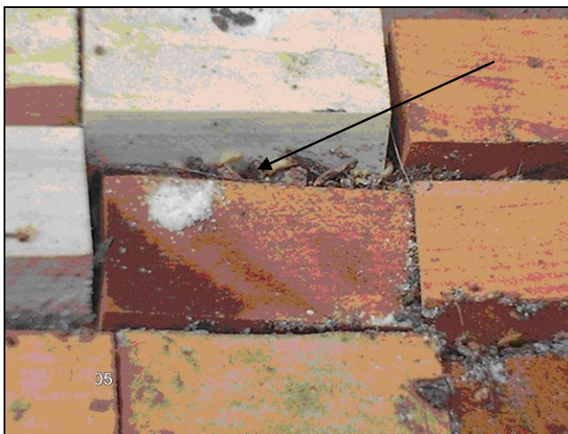
Figura 8. Túneles de termita subterránea en terreno.
