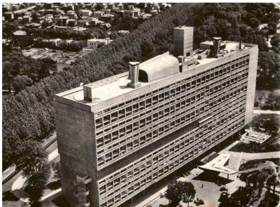
Figura 2. Unidad habitacional de Marsella
