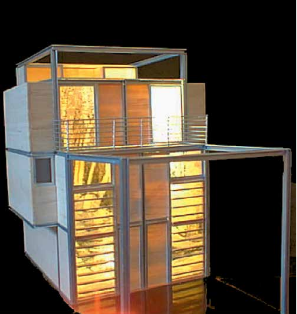
Figura 4. "Chasis" habitable revestido con paneles prefabricados de madera contrachapada
