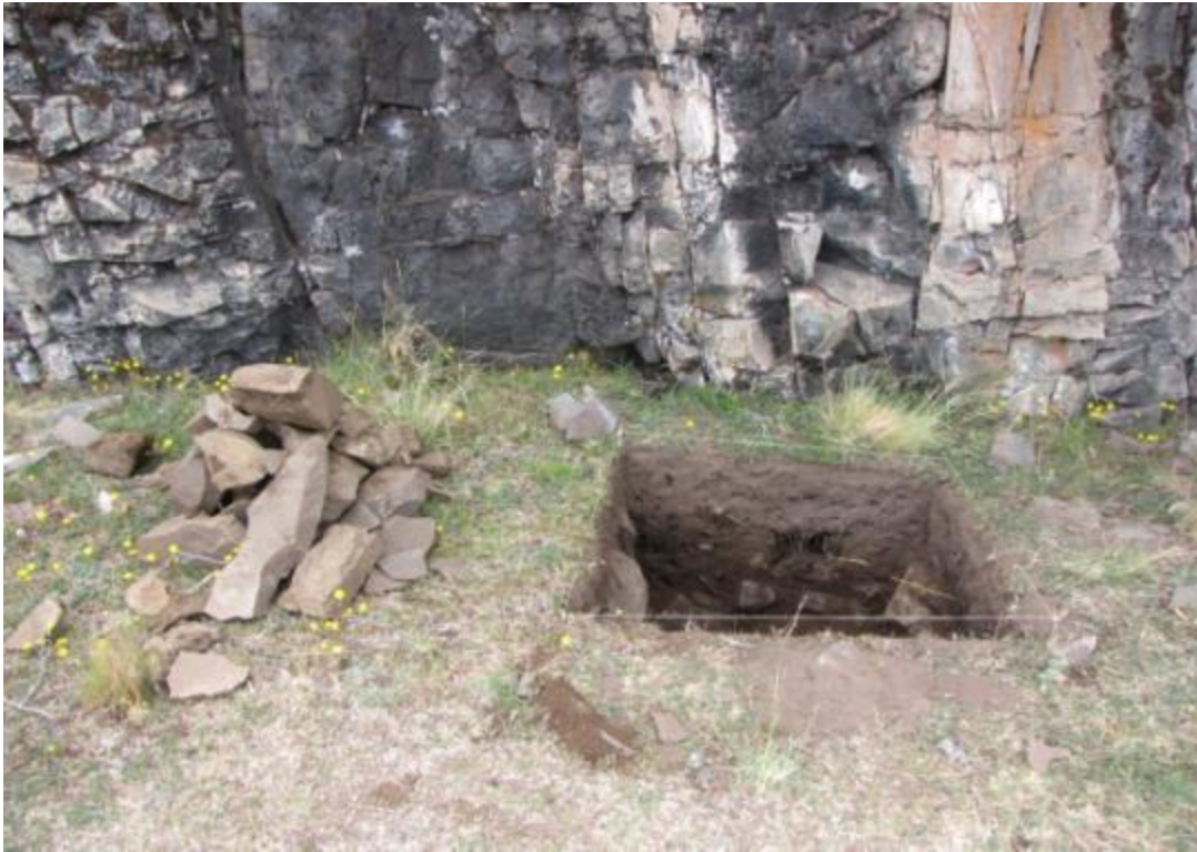
Figura 17: Excavación de sondeo en borde de reparo BN36.
