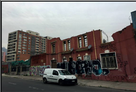
Figura N° 35. Contraste entre casona deteriorada construida entre 1900-1930 y edificio 2008, calle Santos Dumont
