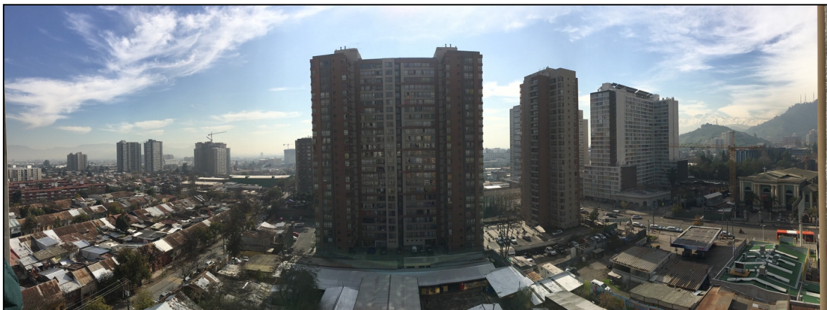
Figura 25. La Chimba. Edificios en el área de estudio
