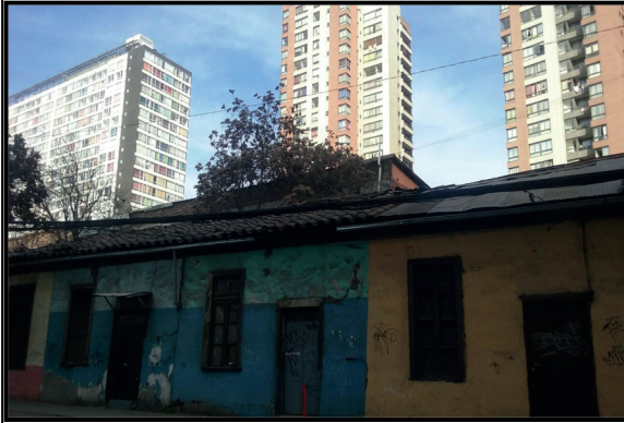
Figura N° 32. Cité por Santos Dumont 1900-1930. Edificio construido 2009.
