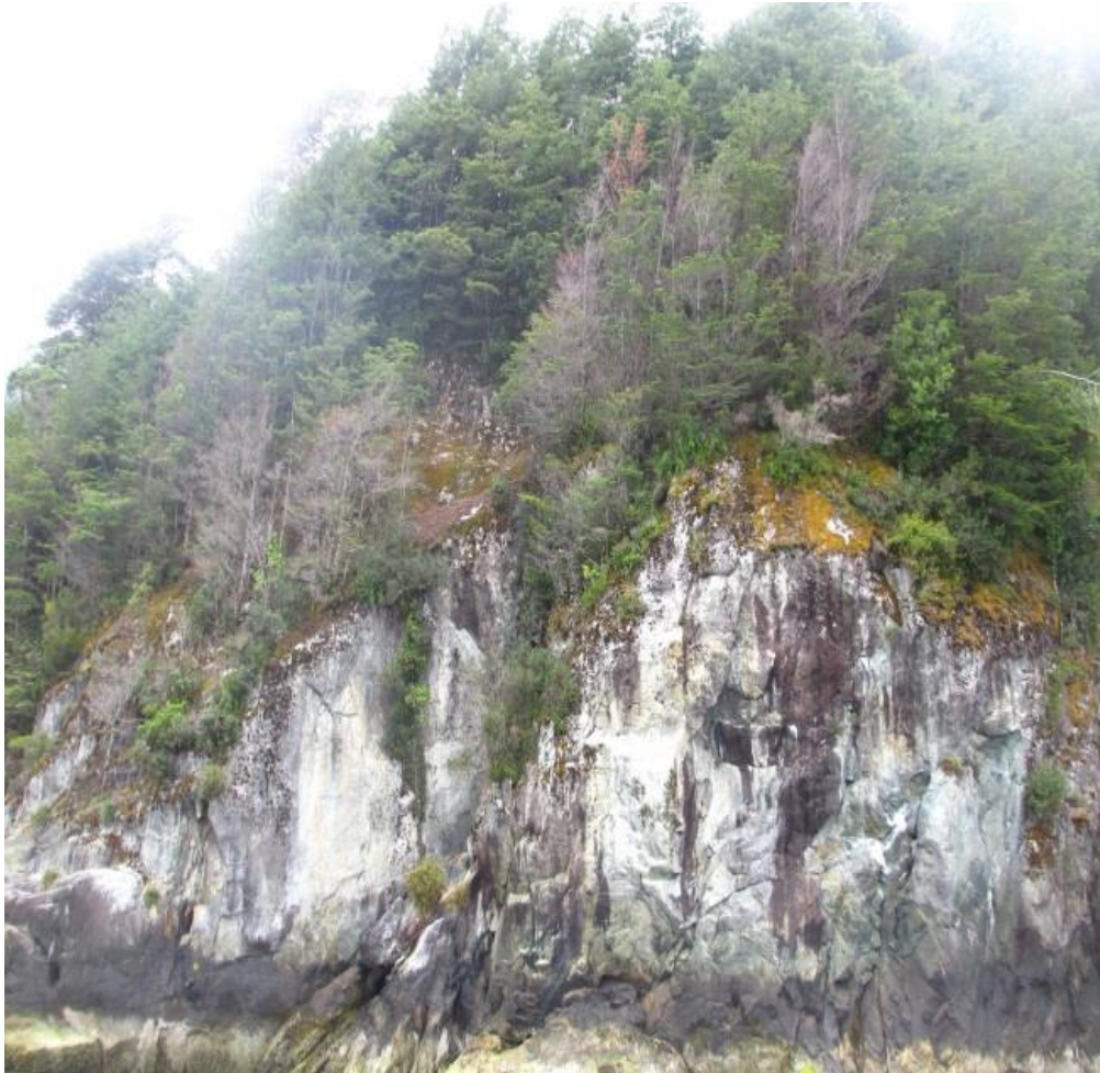
Figura 31: Caída de roca en ladera Este del fiordo. Fuente: FONDECYT N° 1151087.
