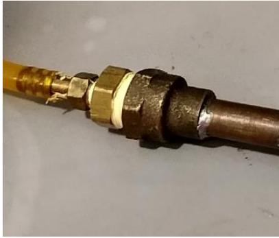
**Figura 3-48: Brazo de la llave cuádruple unido a una manguera**
