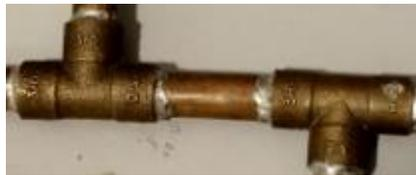
**Figura 3-50: Sistema conector-tubo-conector.**
