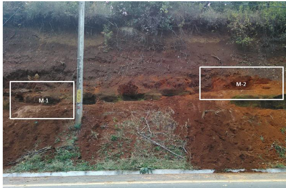
Figura 25: Primer lugar de extracción, Km 40 ruta N-55
