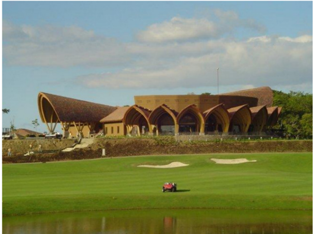
Hotel papagayo, Costa Rica. (Madera laminada, fabricación y montaje de sistemas estructurales. Gomez, J.)
