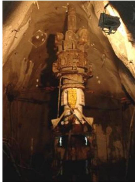
(b) Perforación Mecanizada con Equipo Blind Hole. *Fuente:(Camhi, 2012)*
