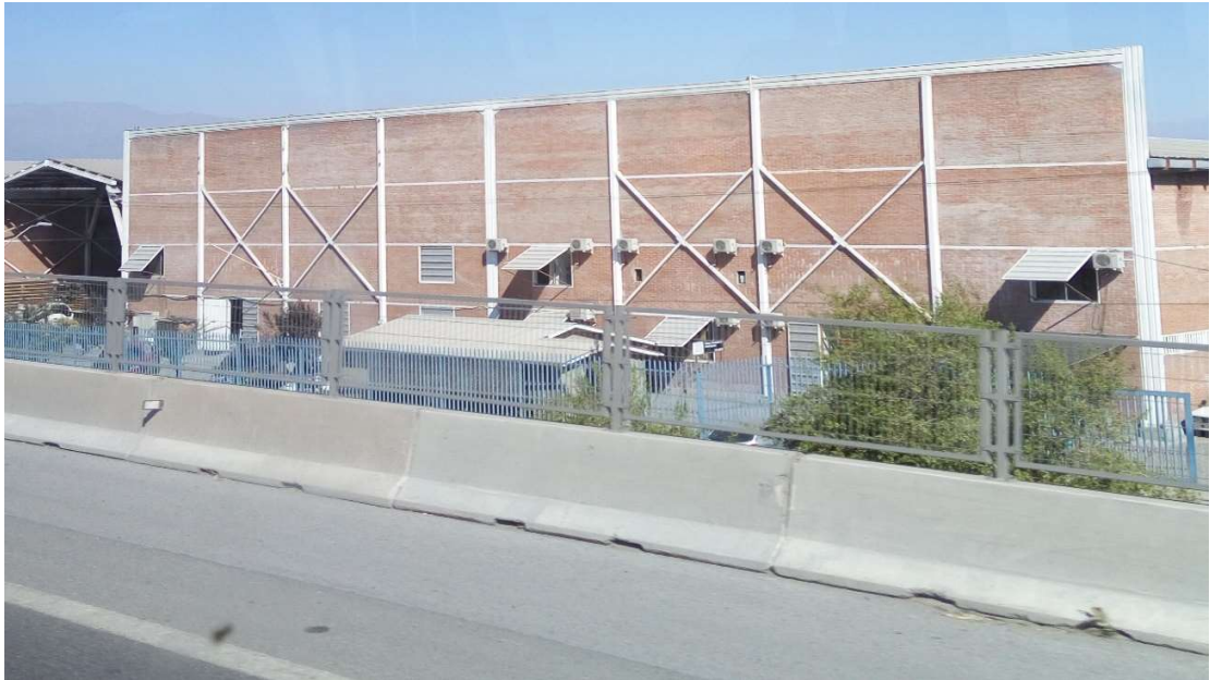
Ilustración 64:Edificio bodega de empresa ESSAAR, vista frontal de fachada.
