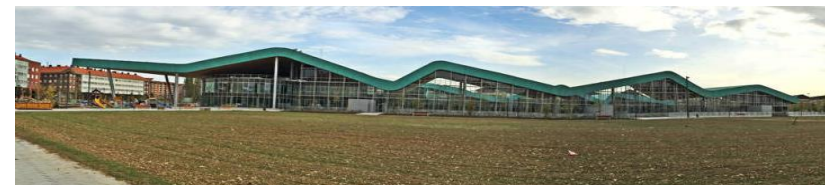
Estación de Buses de Victoria
