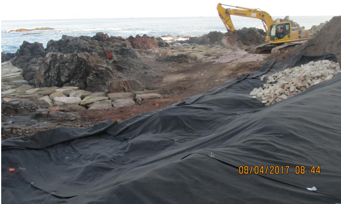
Foto 5 – Movimiento de Tierra y enrocado Fuente: Constructora FV
