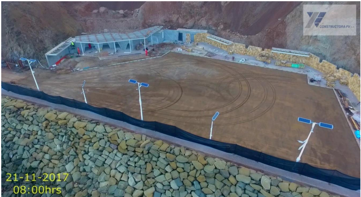
Foto 6 – Sector de estacionamientos y locales comerciales Fuente: Constructora FV
