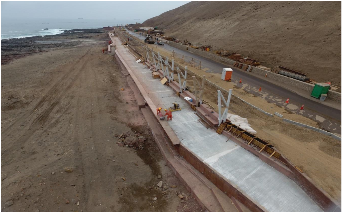
Foto 1 – Camino costero Fuente: Constructora FV
