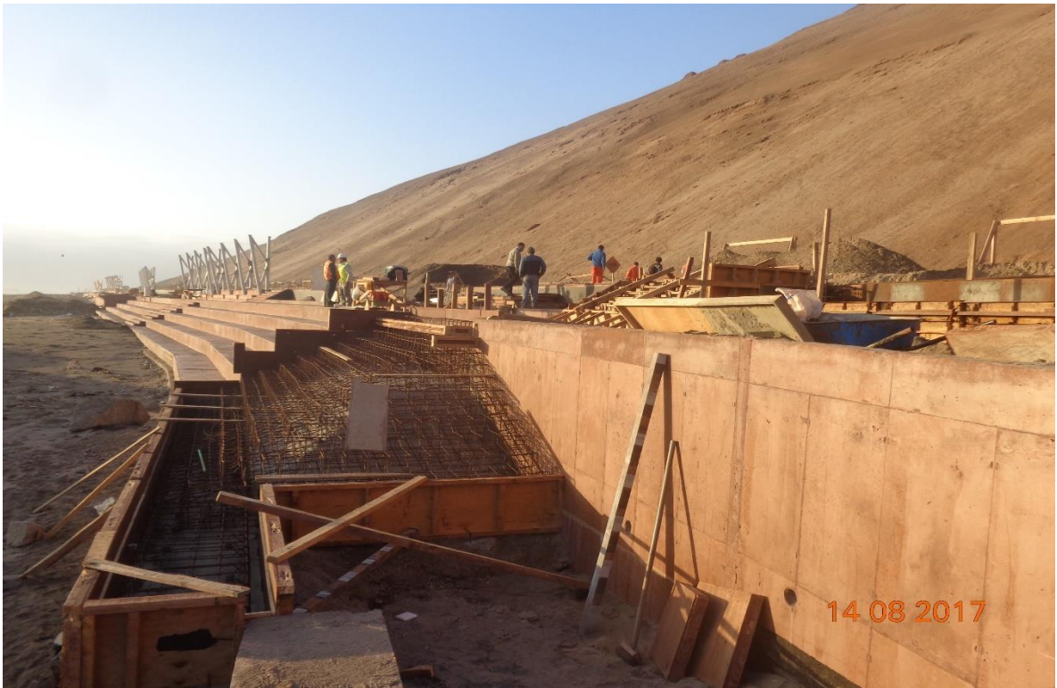
Foto 3 – Acceso a Playa Corazones Fuente: Constructora FV
