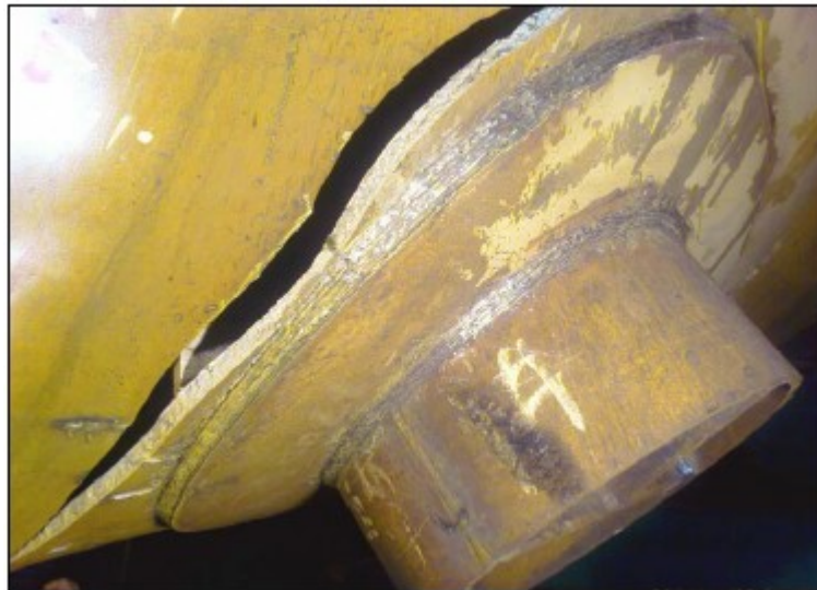
Figura 2.11: Falla en estanque a presión debido a carga externa [9]
