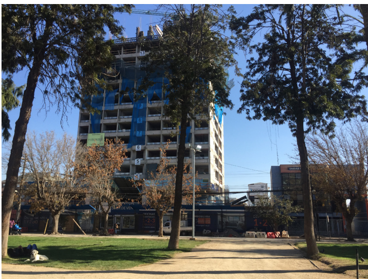
Fig. 35 "Edificio Monumento" de la inmobiliaria Gestora, de 17 pisos (en construcción). Desde Plaza Monumento y "Calle Gral. Ordoñez".
