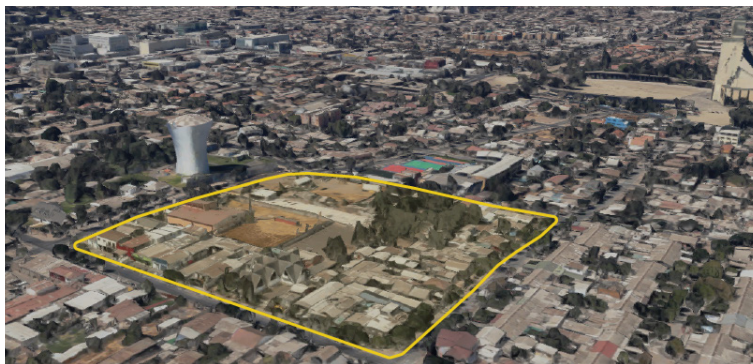
Fig. 40 Foto panorámica del terreno desde esquina Gral. Las Heras con Libertad. Vista hacia Templo Votivo y Plaza Maipú.
