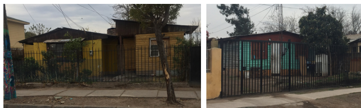
Fig. 45 Fotos de viviendas deterioradas en la manzana, desde calle Gral Las Heras.
