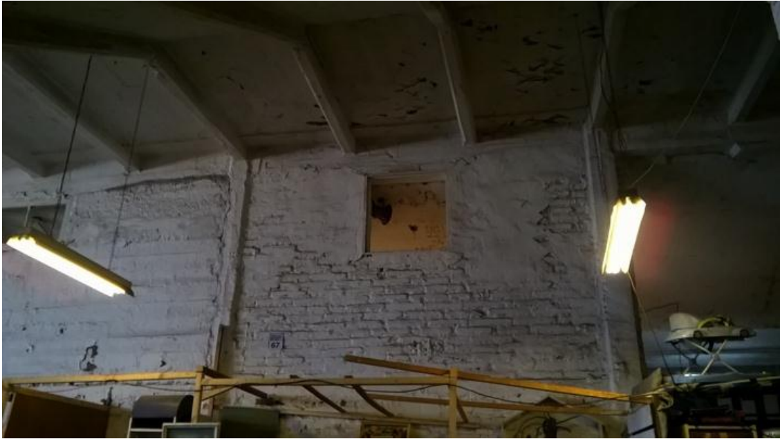
“La voz del Persa”. Instalación de megáfono en muro ciego. Galpón antigüedades
