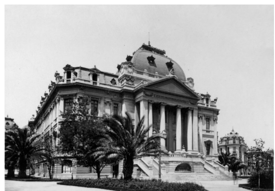
Fig. 18. Edificio de La Escuela de Bellas Artes de Chile, inaugurado en 1910. En ese lugar la Escuela de Artes Decorativas funcionó hasta 1927.
