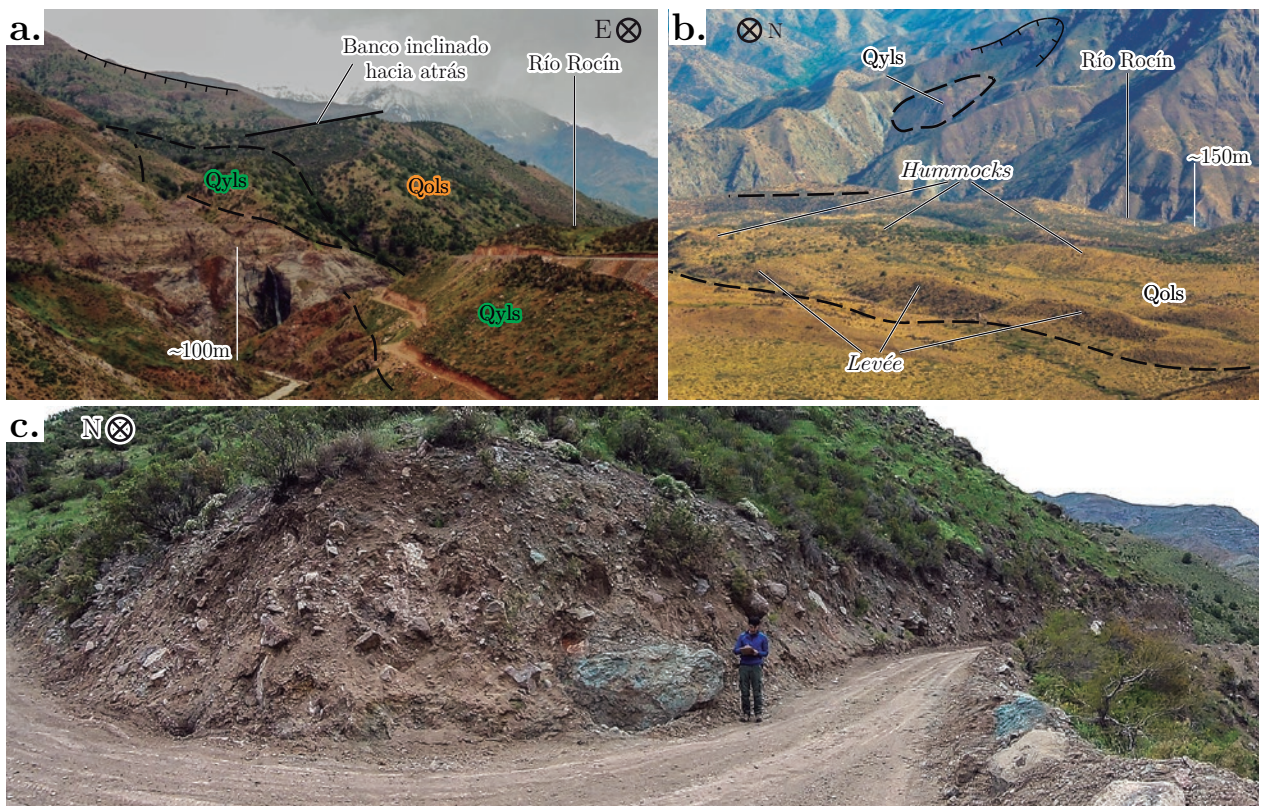
Figura 5.8: Fotografías de los depósitos de megadeslizamientos en el valle del río Rocín (puntos de vista de las fotografías se indican en la Figura 5.7 a). (a) Fotografía de Qyls y Qols, de los tipos deslizamiento y avalancha de rocas, respectivamente. Qols corresponde al megadeslizamiento: «Avalancha de roca Los Maquis» sobre el cual se preservan de manera parcial algunas morfologías de levée y hummock . (b) Fotografía de Qyls y Qols de los tipos avalancha y deslizamiento de rocas, respectivamente. Se observan las relaciones laterales de corte entre Qyls y Qols, así como el contacto de los depósitos con el sustrato rocoso. Qols exhibe la morfología característica de banco inclinado hacia atrás. (c) Fotografía de depósitos de avalancha de rocas en el que se observa bloques angulosos, que ocasionalmente alcanzan dimensiones métricas, inmersos en una matriz tamaño arcilla y limo.
